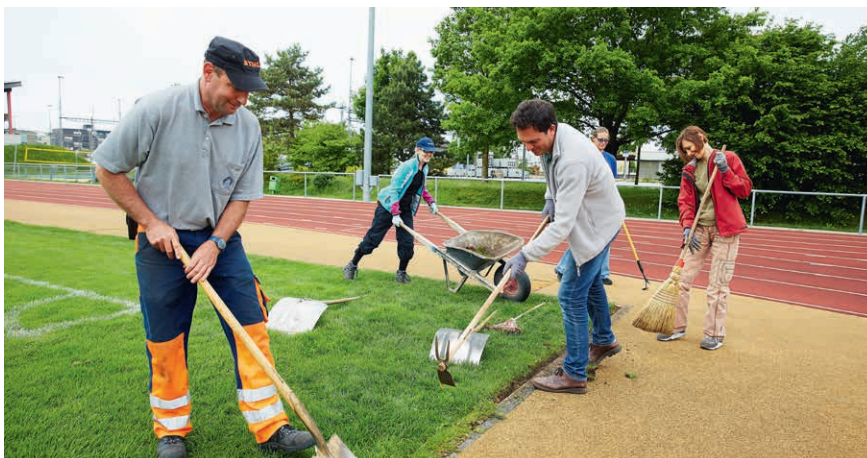
Eine Gruppe Mitarbeiter vom Novartis-Standort Rotkreuz führt gemeinsam mit Mitarbeitern der Gemeinde Unterhaltsarbeiten im Sportpark Rotkreuz durch.
